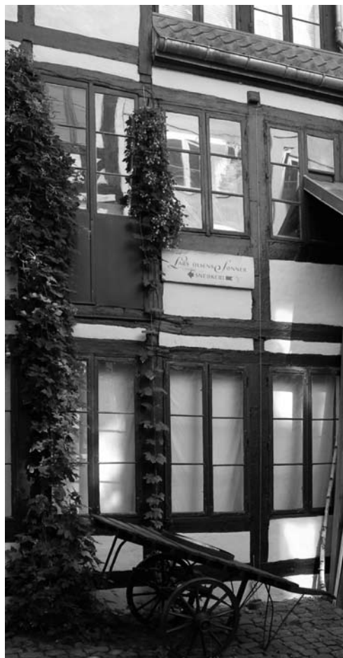
Værkstedet i baghuset i Krystalgade
