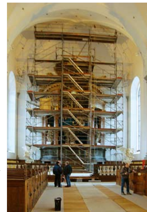
Rundt om altertavlen er der monteret et kæmpe stillads
