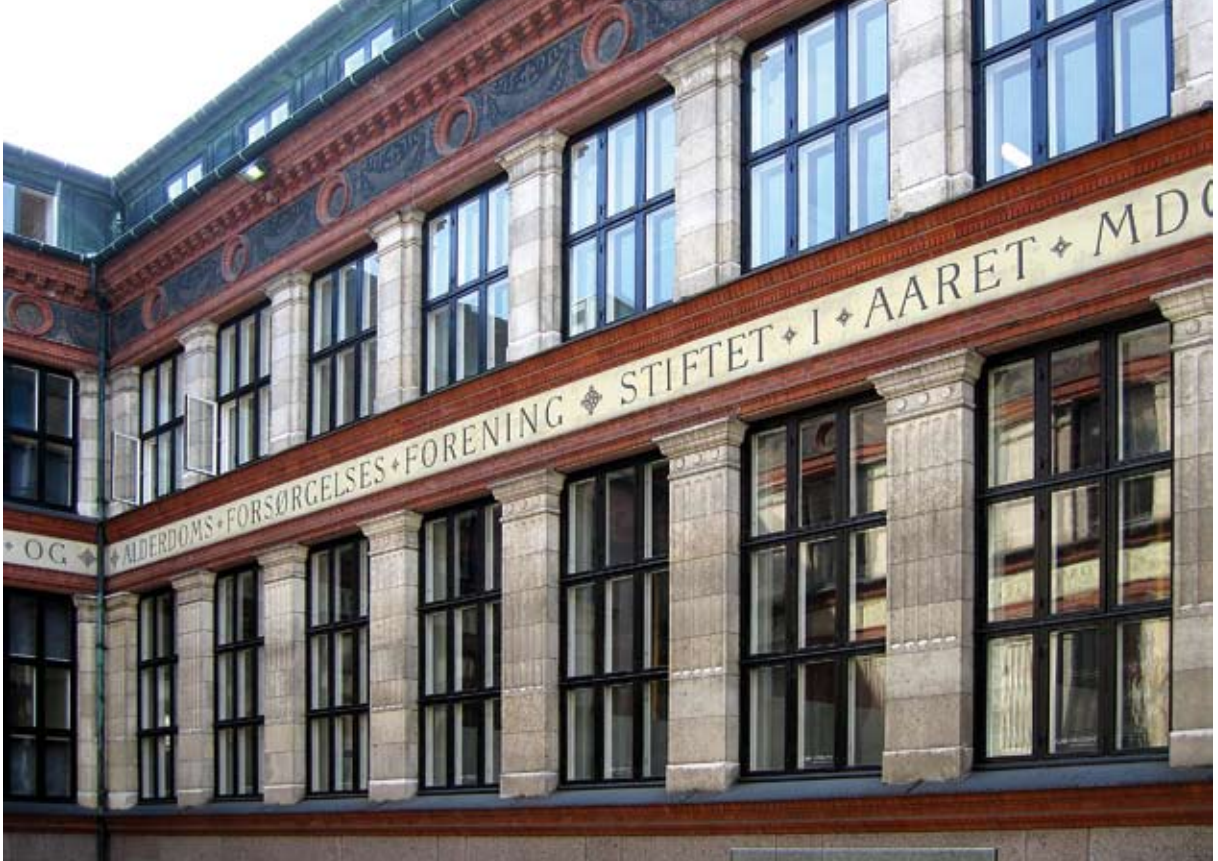
Den fint restaurerede gård i Bikubens første hovedsæde på hjørnet af Silkegade og Pilestræde
