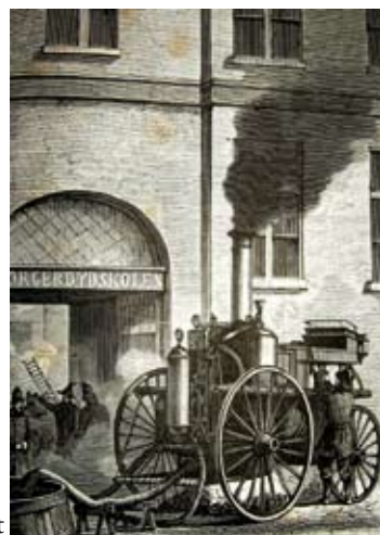
Dampbrandsprøjte i arbejde
