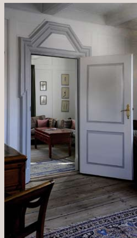
Den smukt restaurerede dør med gerigter som sjældens ses.
