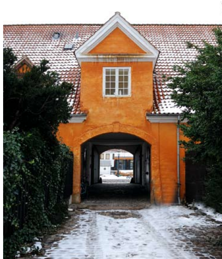
Materialgården med et kig ud igennem porten til Frederiksholms Kanal
