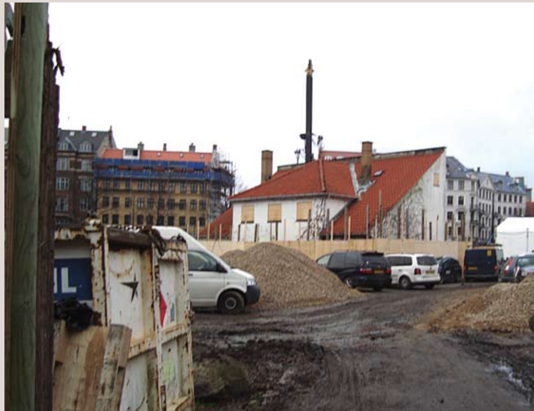
Trods manglende lokalplaner arbejdes der på fuld kraft på byggepladsen. Det fredede graverhus ses midt for.
