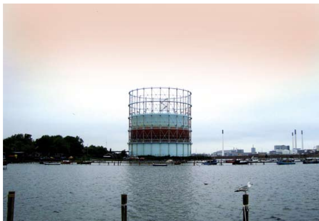
Gasbeholderen er et stykke historie ikke mindst på det tekniske område.
