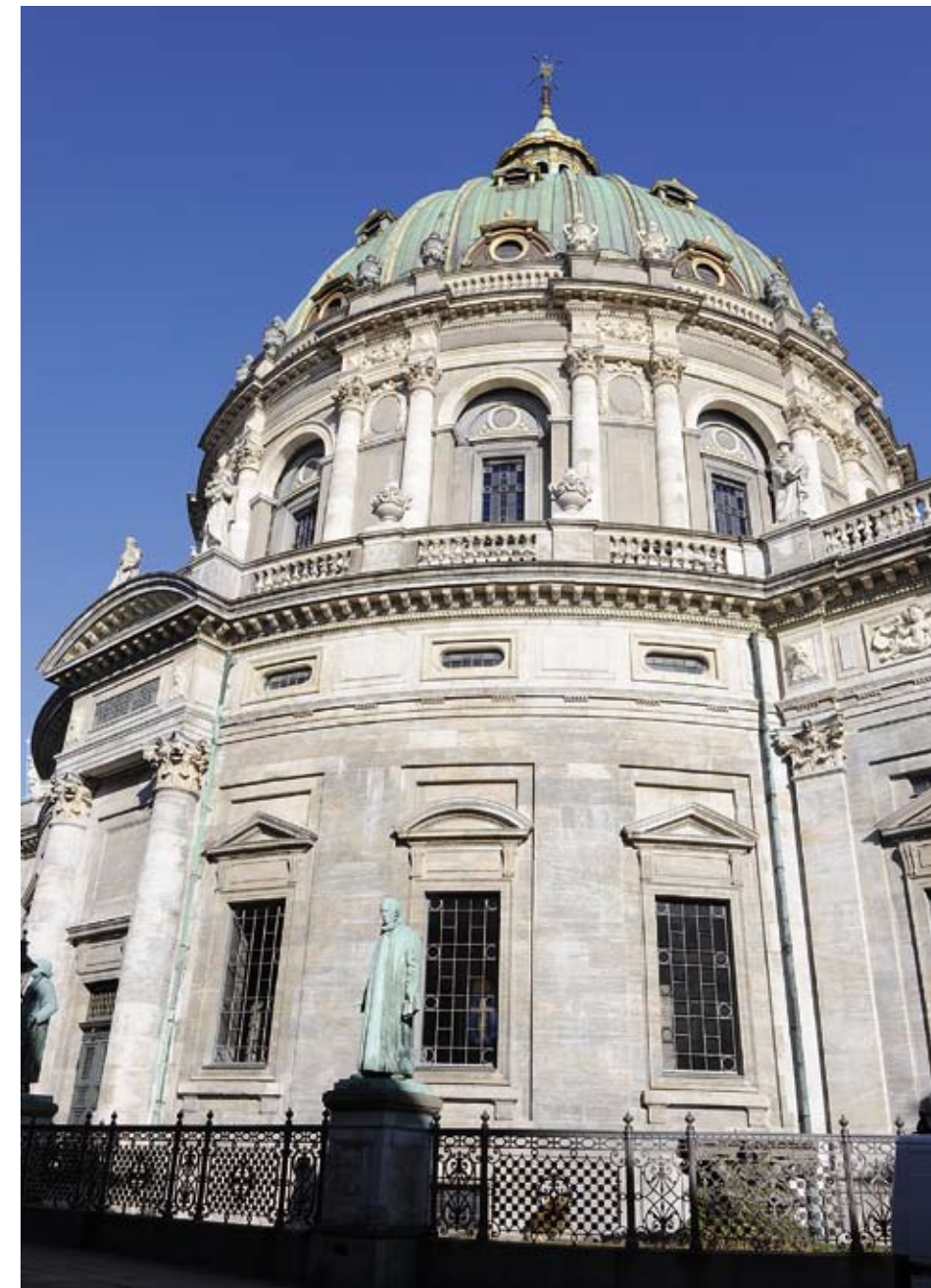
Til venstre ses det fine gamle rækværk som skal restaureres. Herover ses kirkens smukke kuppel, som forhåbentlig holder til Metrobyggeriet.
