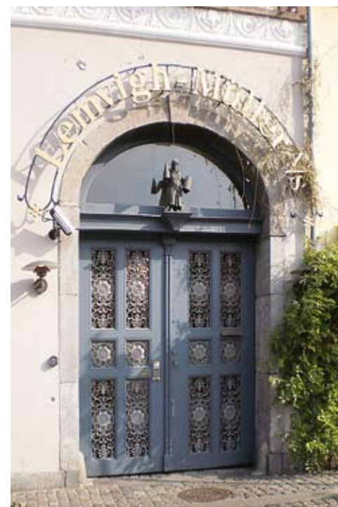
Behagens Gaard i Strandgade 26. Ser man efter, kan man med det blotte øje se, at der oprindeligt var ensartethed mellem nummer 26 og 28. Porten var i det midterste hus men blev flyttet ud i venstre side. Det der i dag udgør nummer 26 blev i 1760 overtaget af hamborgensen Gysbert Behagen, der samme år blev ansat i sin svigerfars handelsfirma. Han blev også grosserer og tiåret efter sad han i direktionen for Asiatisk Kompagni. Behagen slog de to ejendomme sammen og byggede en etage mere på ejendommen. Ornamentikken foroven har årstallet 1769 stående og et stort "B". Gysbert Behagen kaldte herefter sin ejendom for Behagens Gaard.
