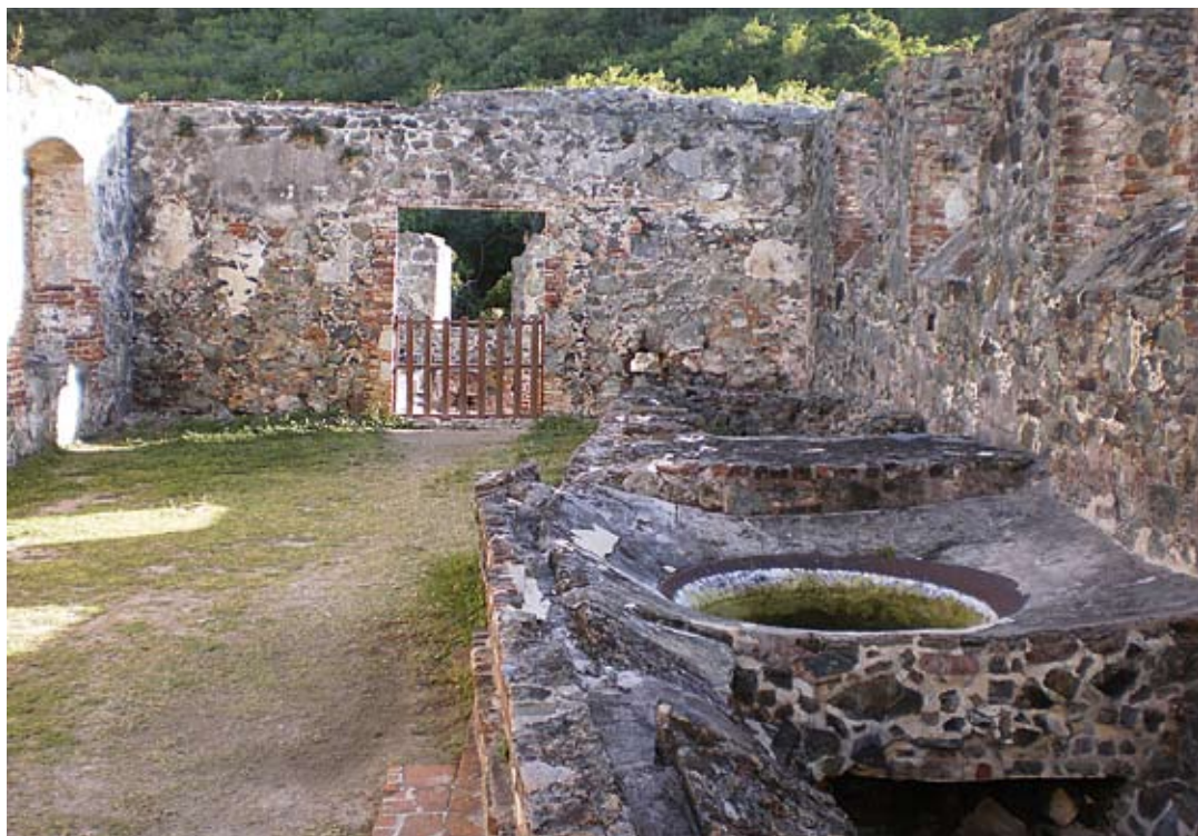
I ruinen Annaberg kan man se hvordan et kar af de typisk fire er bevaret. Under karet kan skimtes hullet hvor ild gav varme til indkogningen. Langs karene ses en afløbssrende til biprodukter og affald. Annaberg er det bedst bevarede på Skt. Jan (i dag St. John).
