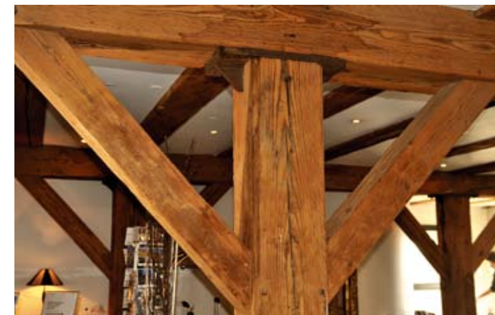
De solide bjælker og stolpekonstruktioner har kunnet bære en enorm vægt fra de ovenover liggende etager
