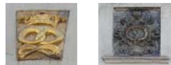
De fine ornamenter på ejendommene Torvegade 22 og 28.
