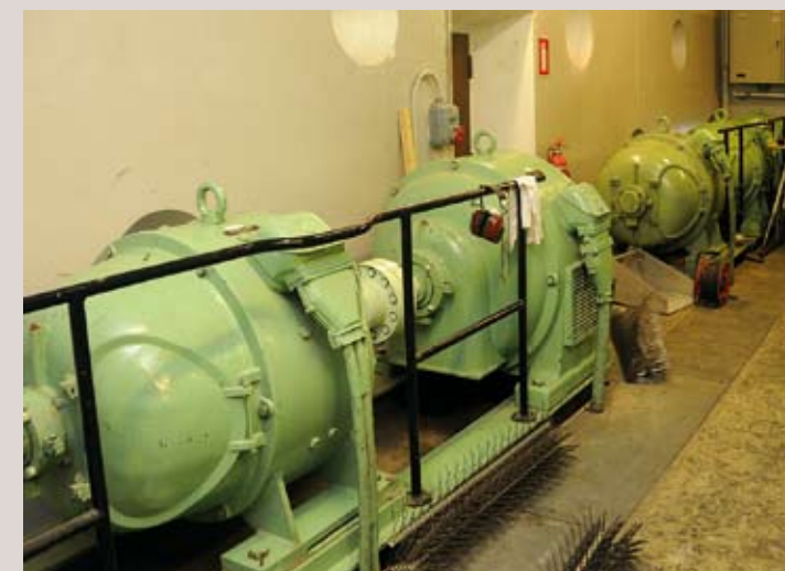
De to systemer med en vekselstrømsmotor og to jævnstrømsdynamoer, der driver broklappen på hhv. Amager og Københavnsiden.
