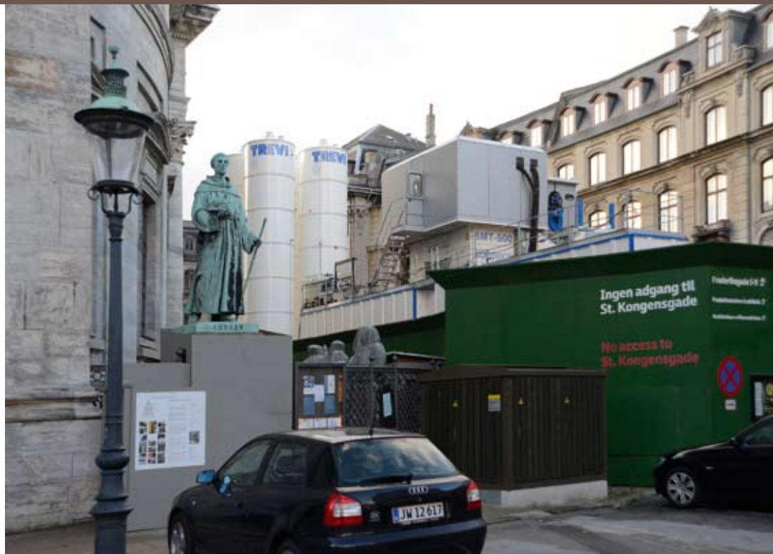
Metrobyggeriet ved Marmorkirken
