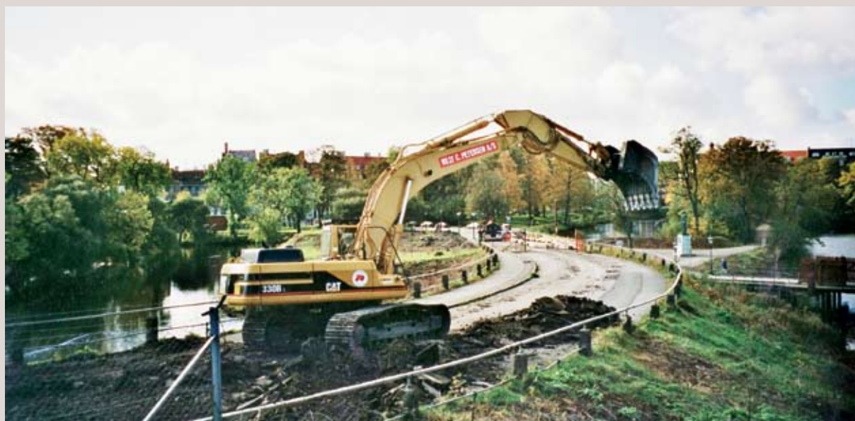
Der måtte store gravemaskiner til at udføre meget af det tunge arbejde.
