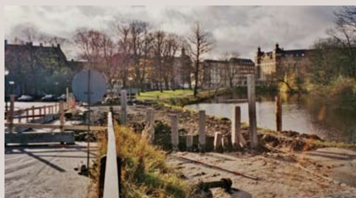
Ny bro under anlæg, november 1998.
