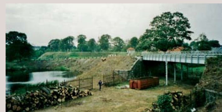
Adgangsvej og viadukt fjernes, september 1998.
