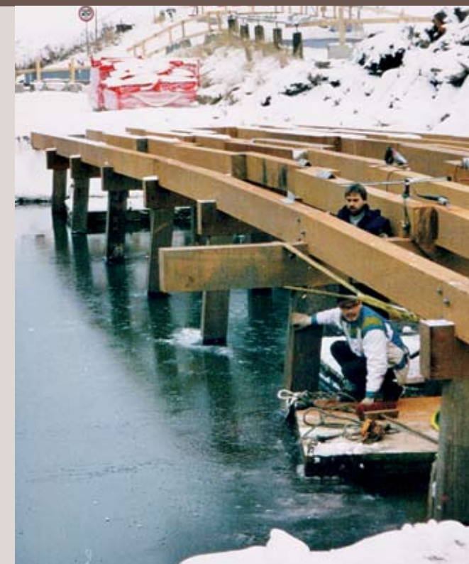
Gave brobyggere i vintervejret i 1999 i færd med at samle bærende brobjælker med bolte fra en tømmerflåde.
