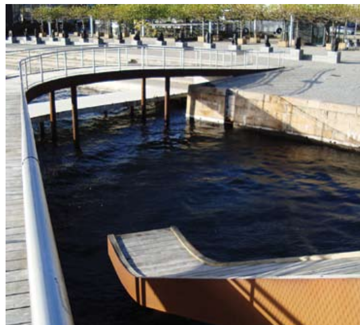
Den nybyggede vandrutschebane til kajaker, der blev lukket fra starten.
