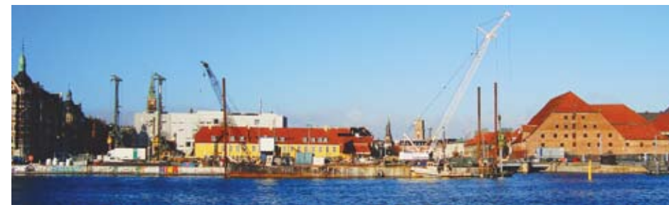
Byggeriet på Bryghusgrunden der nu fjerner den sidste havnefront.
