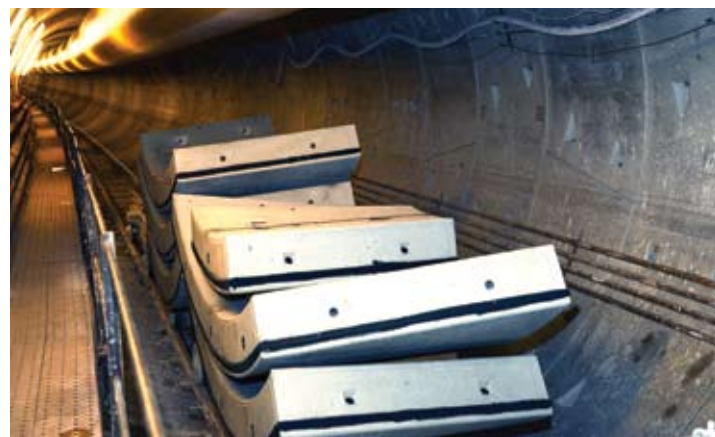
Tunnelementerne består af 6 dele, der samles for hver 140 meter tunnel
