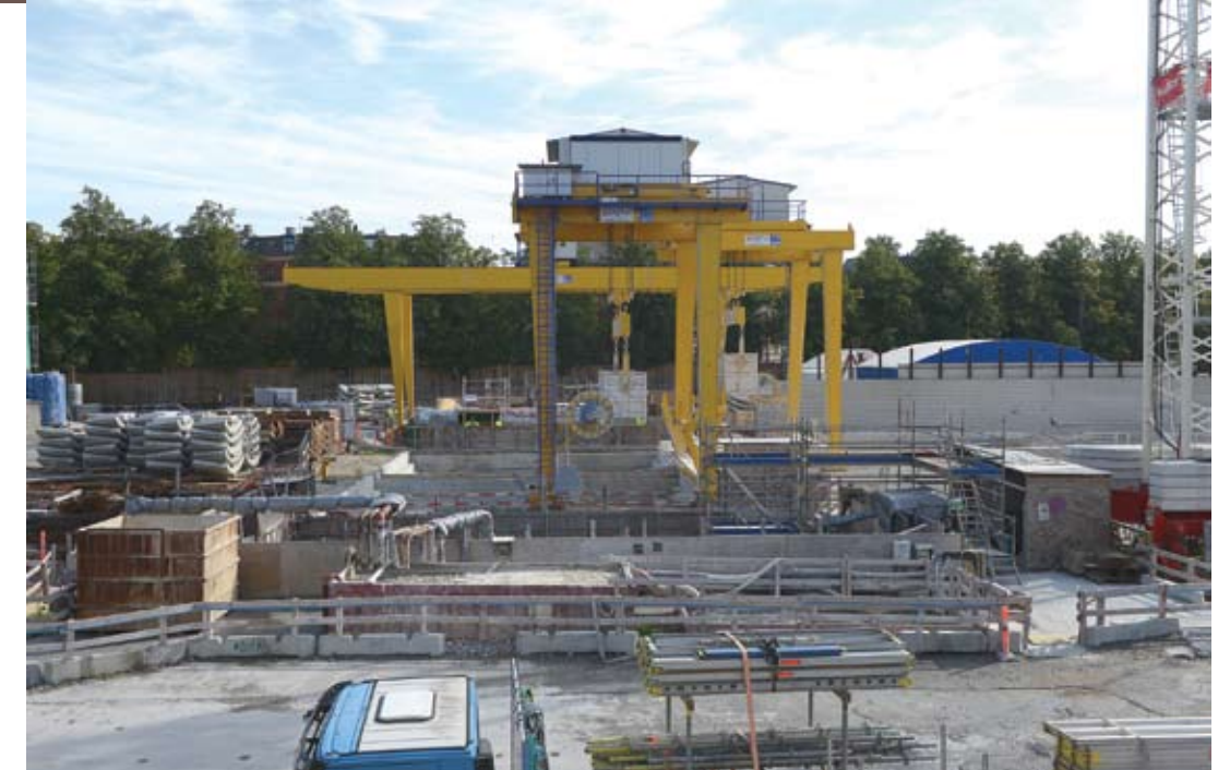
Den store kran løfter containeren med byggeaffald op og vipper det ud i et bassin, hvorfra det læsses på lastbil og køres til Nordhavn til opfyldning
