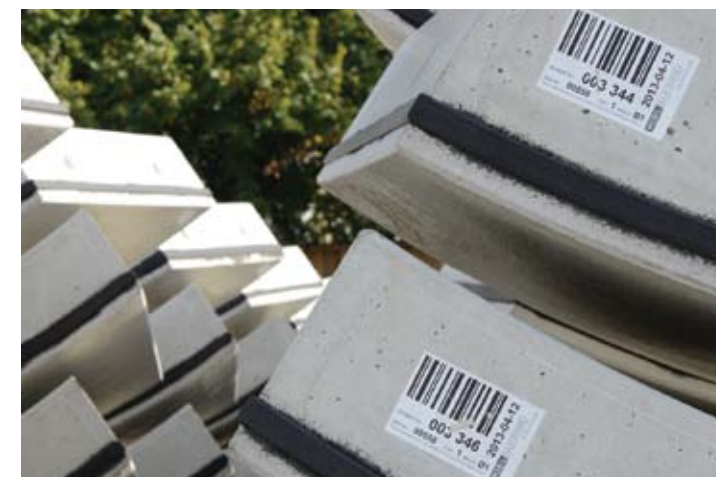
Alle elementer er nøjagtigt nummererede, for de har hver sin plads i tunnelen og kan senere efter endt byggeri elektronisk overvåges
