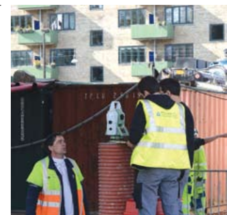
Måleapparatet har forbindelse til en føler på ejendommen overfor, så man hele tiden kan måle, om ejendommen påvirkes af rystelserne
