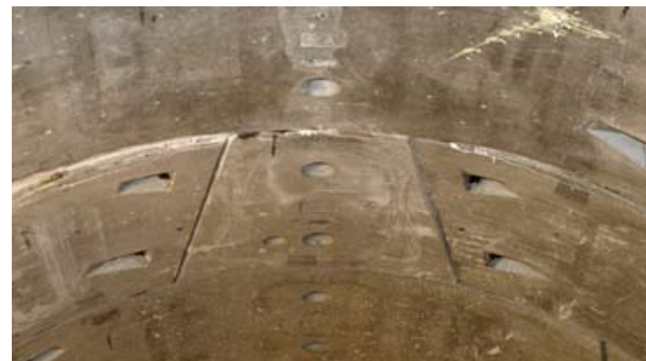
Her ses en samlet tunnelring med læseelementet i midten.
