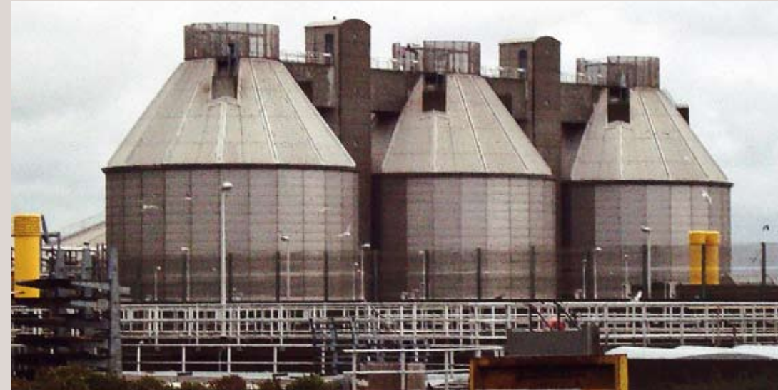
Rådnettankene på Lynetten, hvor der udvindes biogas
