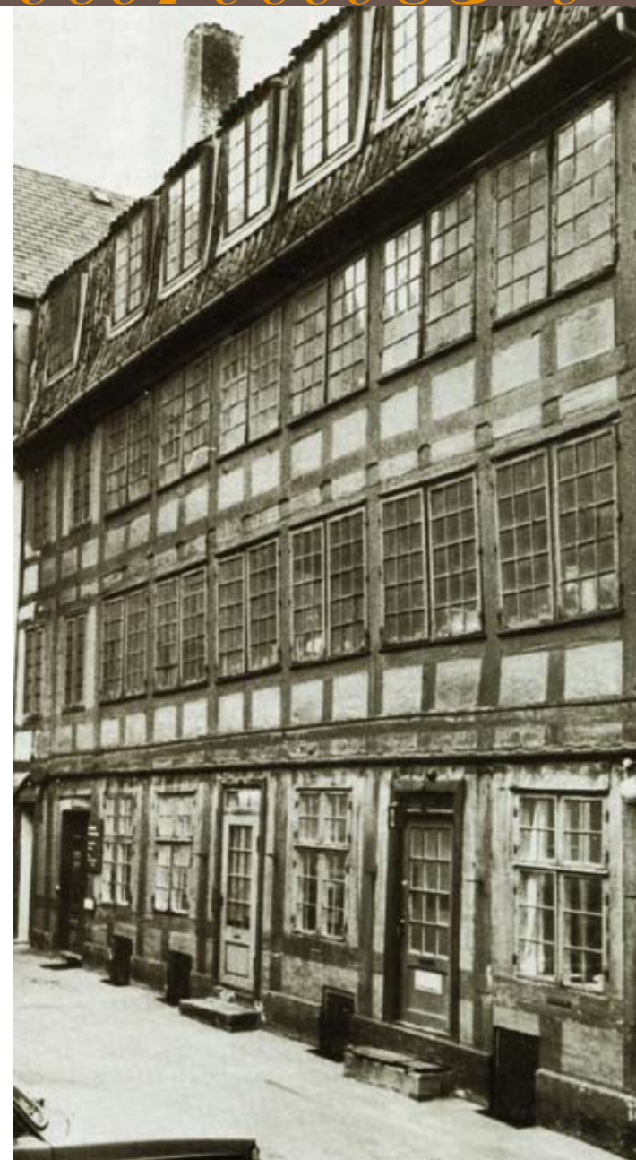
Den gamle silkefabrik i Bredgade
