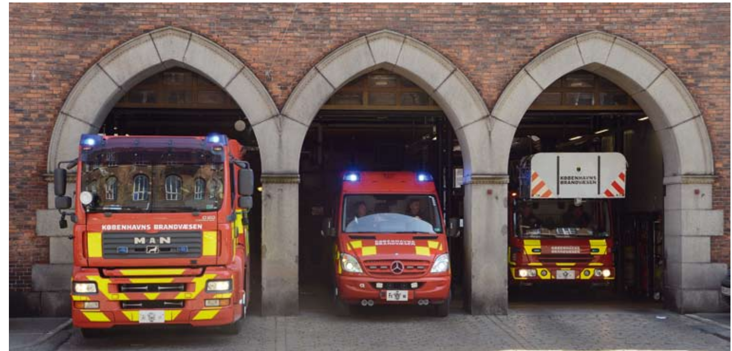
De store, moderne udrykningskøretøjer kan lige akkurat være i den gamle brandstation
