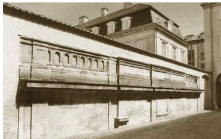
Oprindelig balustrade uden udsmykninger genopsat på mur ind mod museet.
