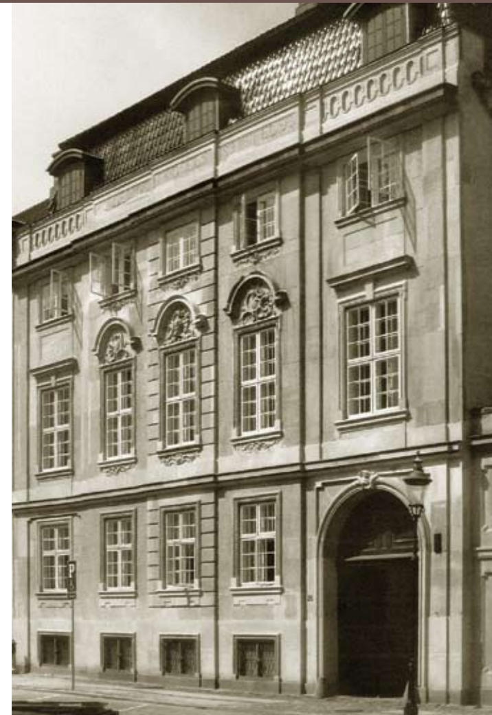
Facade efter renovering.
