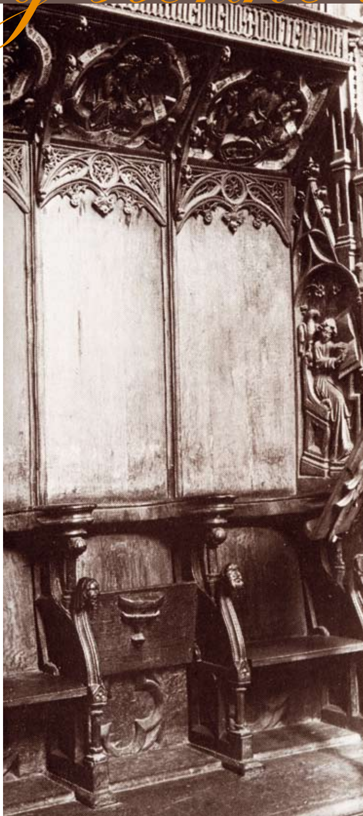
Kannikestole i Roskilde Domkirke. Da flere af messens led skulle overværes stående, kunne de ældre kanniker blive trætte i benene. Derfor er der på undersiden af stolesædet monteret et lille stykke træ, som kunne give støtte, når sædet var klappet op. Sådanne støtter kaldtes "misericordier" efter det latinske ord for barmhjertighed.
