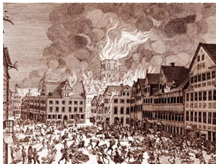
Et udsnit af Amagertorv under den store brand i 1795
