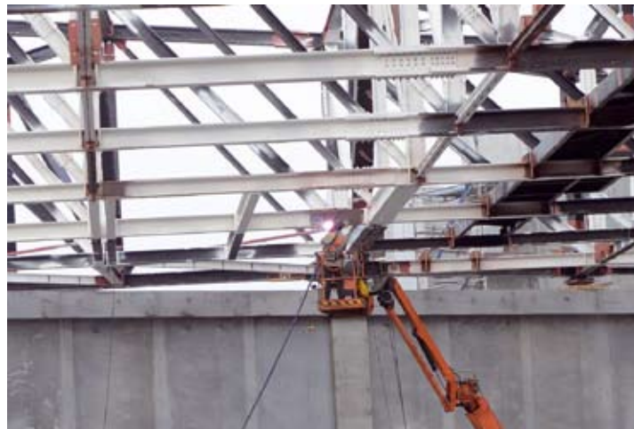
De store tagspær har et frit spænd på 100 meter
