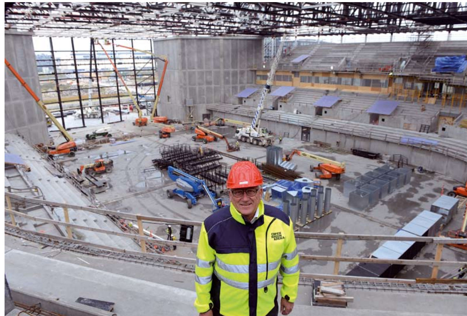
Bestyrelsesformand Bent Frank viser rundt i den store arena, der kan huse op til 15.000 gæster
