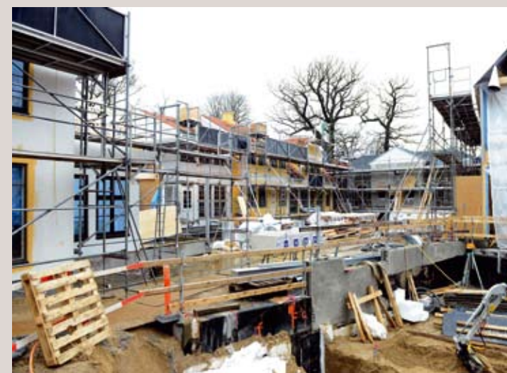
Håndværkerne har stadig travlt med færdiggørelsen af Korsbæk, men nu kan man tydeligt se, at de enkelte huse begynder at få deres færdige udseende. 30. april skal alt være færdigt til modtagelse af de første gæster
