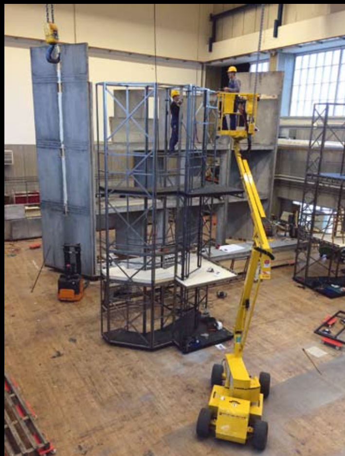
Montagehallen hvor store kulisser prøveopstilles. Her er det muligt at bygge op i 3-4 etager.
