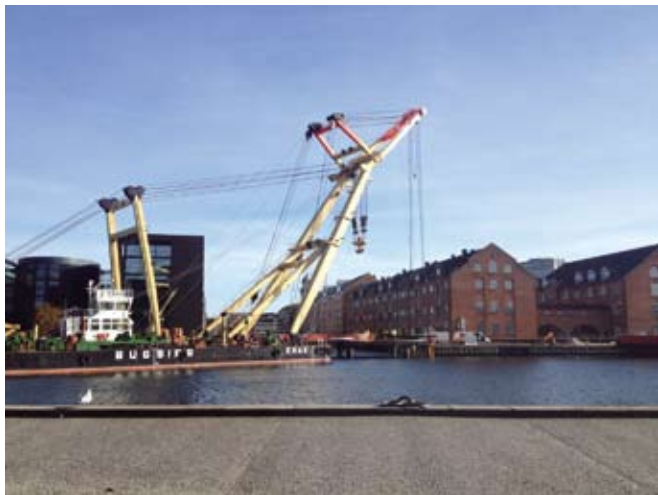
Den store kran, der placerer den nye cirkelbro
