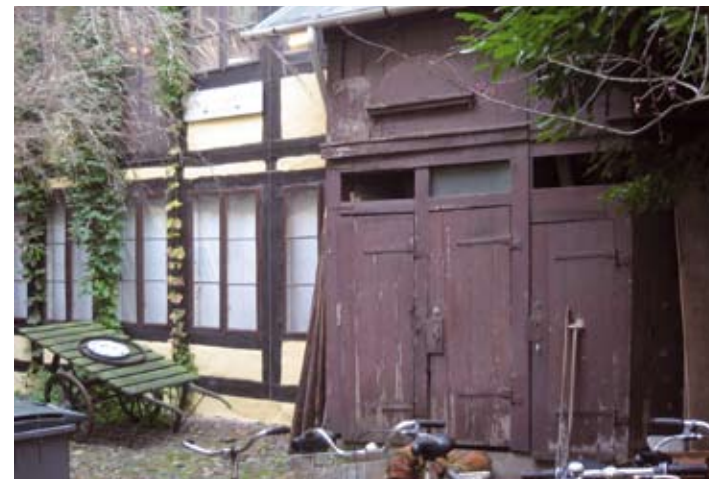
By og Land har også fået fredet Københavns sidste gårdlokummer i Krystalgade
