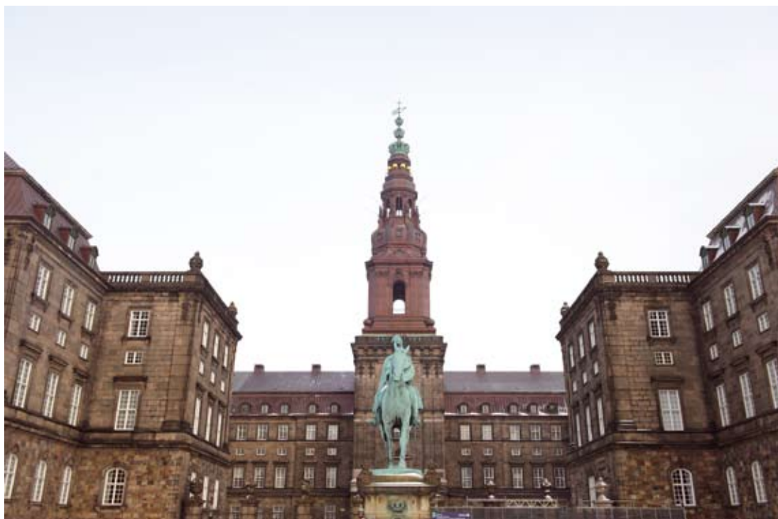
Christiansborg blev officielt anset som færdigt i 1928, men noget byggeri manglede endnu
