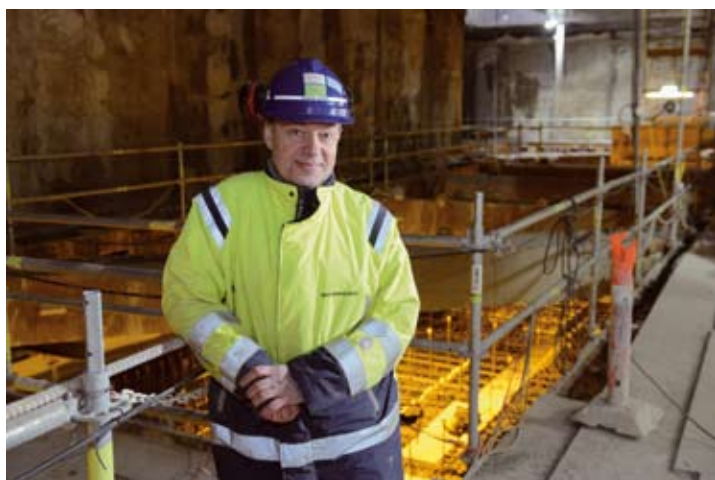
Byggepladsleder Henrik Greve er tilfreds med tidsplanen, og især for, at man nu er kommet helt ned i bunden af skakten og har en stabil kasse, der ikke flytter sig. Det betyder også, at nabobygningerne og især Marmorkirken ikke flytter sig.
