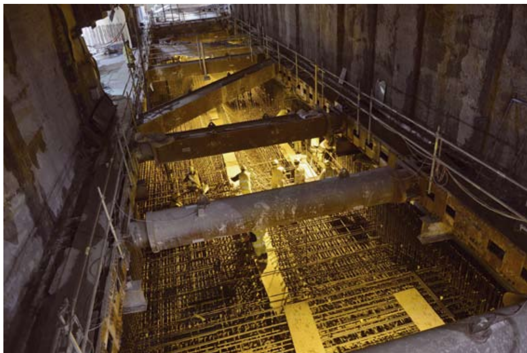
Her arbejder metroarbejdere i 35 meters dybde med at støbe bundpladen. Arbejdet her skal være færdigt meget hurtigt, for tunnelboremaskinen kommer i begyndelsen af måneden.
