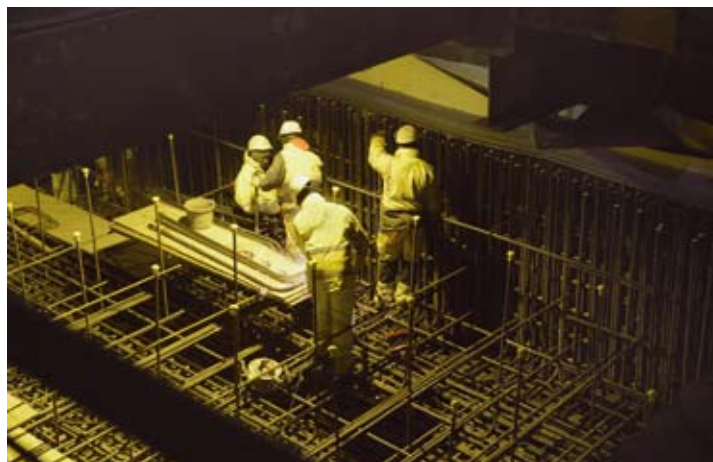
Armeringen af skaktens bund er forarbejdet til støbningen, der stabiliserer hele kassen og bliver underste dæk
