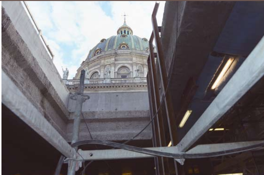
Arbejdet er nu så fremskredent, at byggepladsen oppe formentlig kan afvikles i begyndelsen af 1917.
