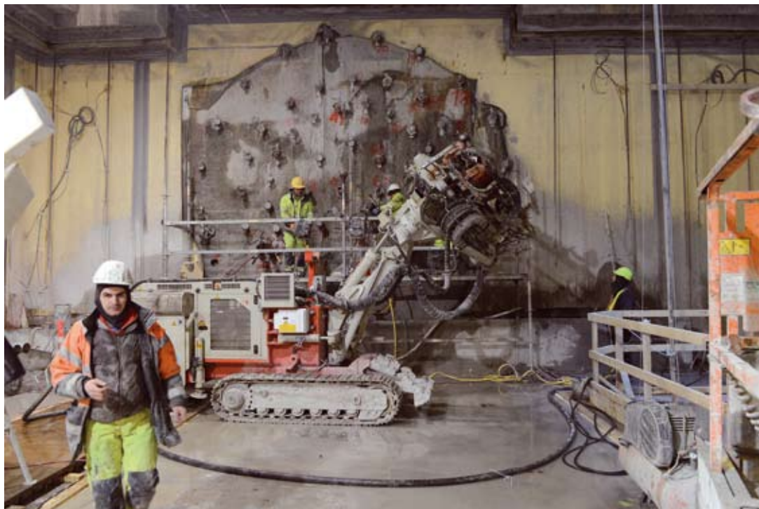
Her er arbejde i gang ved det hul, der skal åbnes for at give plads for tunnelboremaskinen, når skaktens bund er støbt
