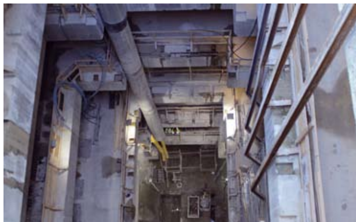
Et kig ned i skakten, hvor bl.a. elevatorerne skal installeres.
