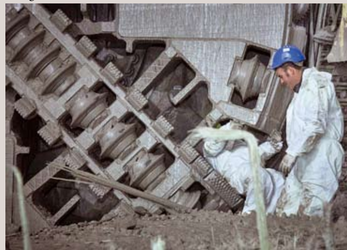
Borearbejderne kravler ud af boremaskinen og ankommer til stationen.
