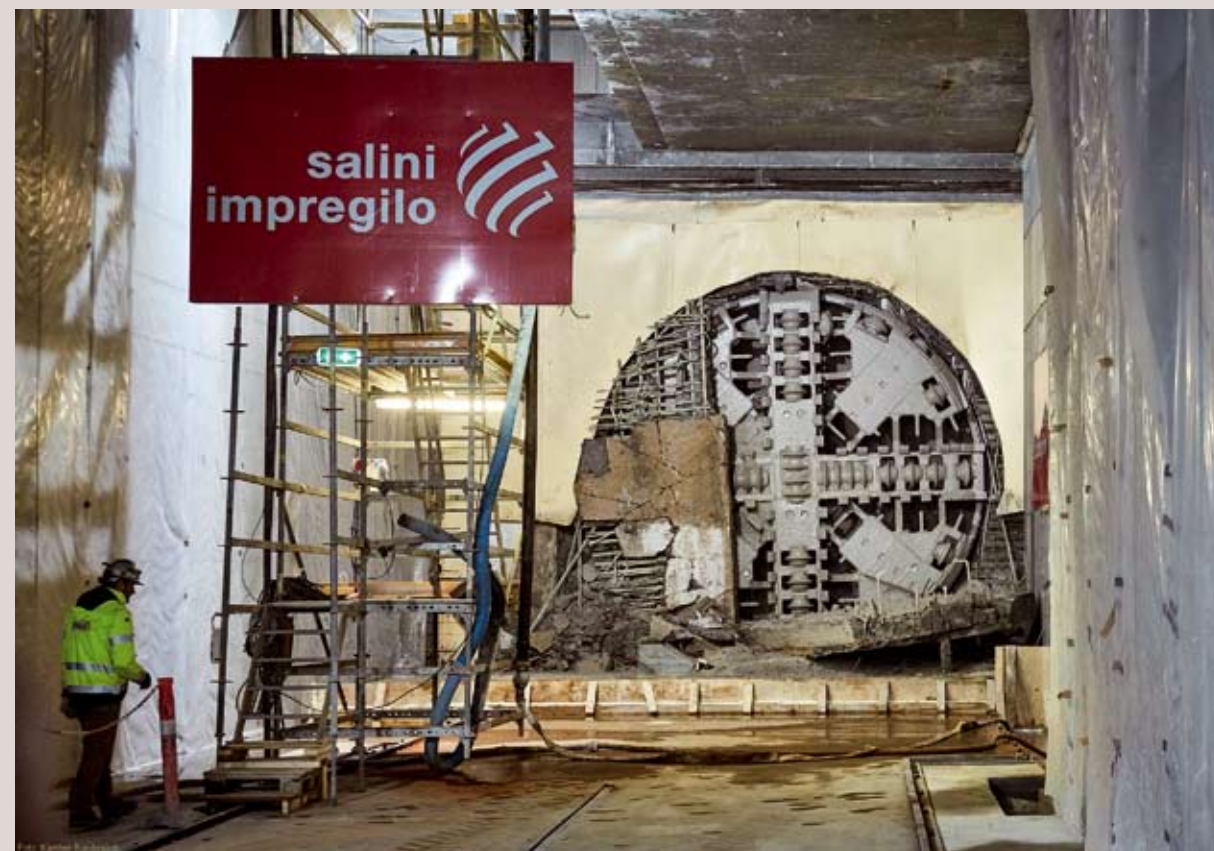
Det store borehoved bryder igennem murene ind til stationen under Marmorkirken
