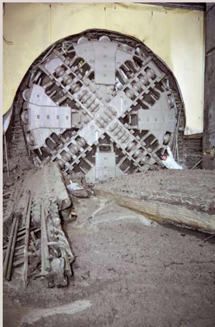
Boremaskinen Nora er kommet ind til den kommende station under Marmorkirken, og den første person kryber ud af borehovedet
