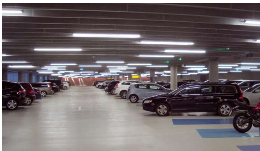
Den længe ventede parkeringskælder under Kvæsthusbroen, nu Ofelia Plads
