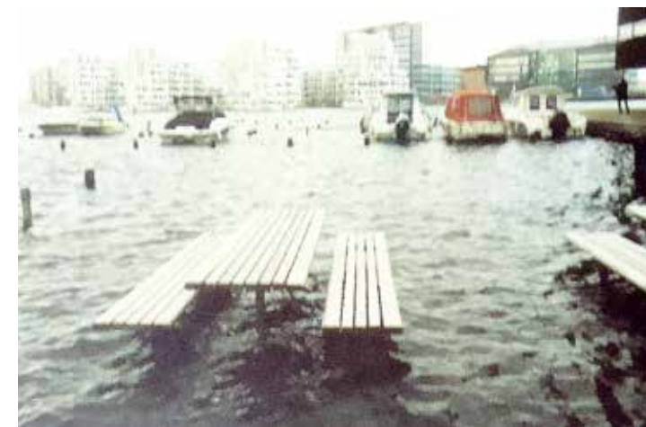
Vandet stiger over bådebroerne men ikke over havnekajen til højre
