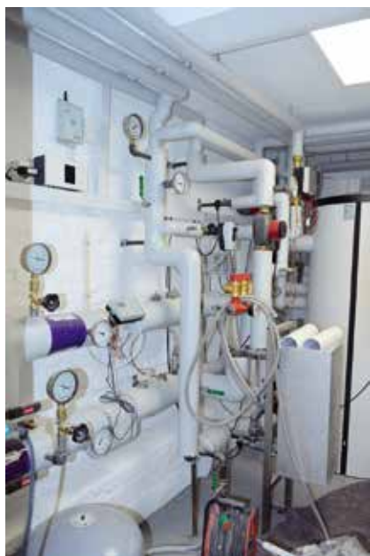
I kælderen er der blevet indlagt fjernvarme, der forsyner de 3 beboelseslejligheder og 2 erhvervslejemål med nutidig varme. VVS-firmaet De Blå Mænd har stået for hele installationen.
