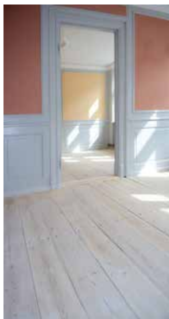
De originale plankegulve er blevet høvlet, slebet og behandlet. Alle de gamle gulve har kunnet bevares.
