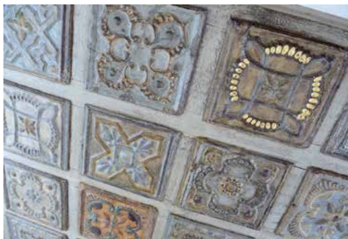
Frellos loftudsmykning med støbte felter i bemalet gips er bevaret.
