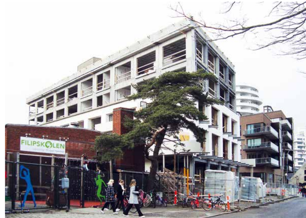
Strandvejen 122 under selve ombygningen
